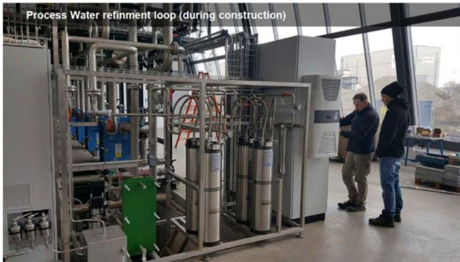
Sistema de ósmosis inversa.
